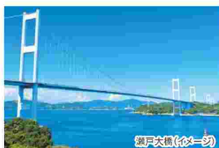
瀬戸大橋(仮一筋)
